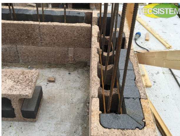
Figura 1. Muratura armata "ISOSPAN".
